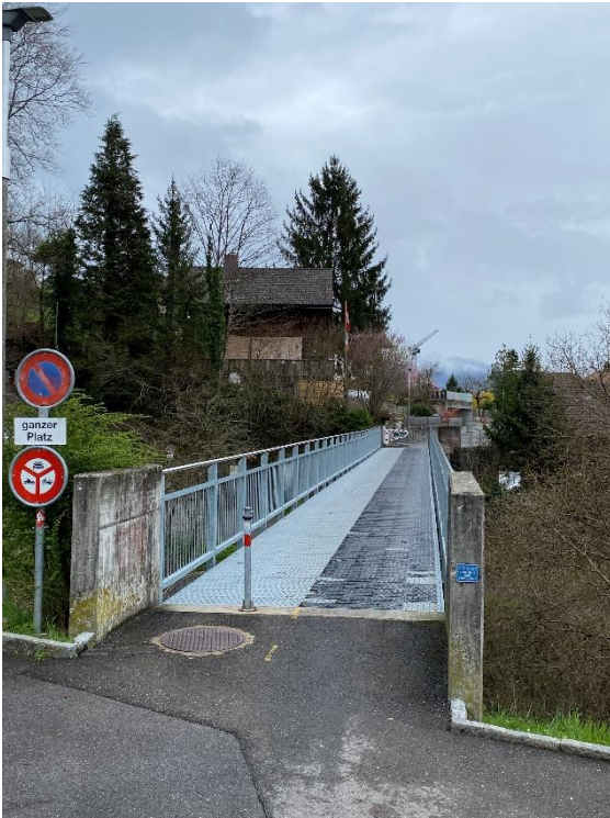
Abb. 1: Ausbau Brücke Dorfbach Hilterfingen
