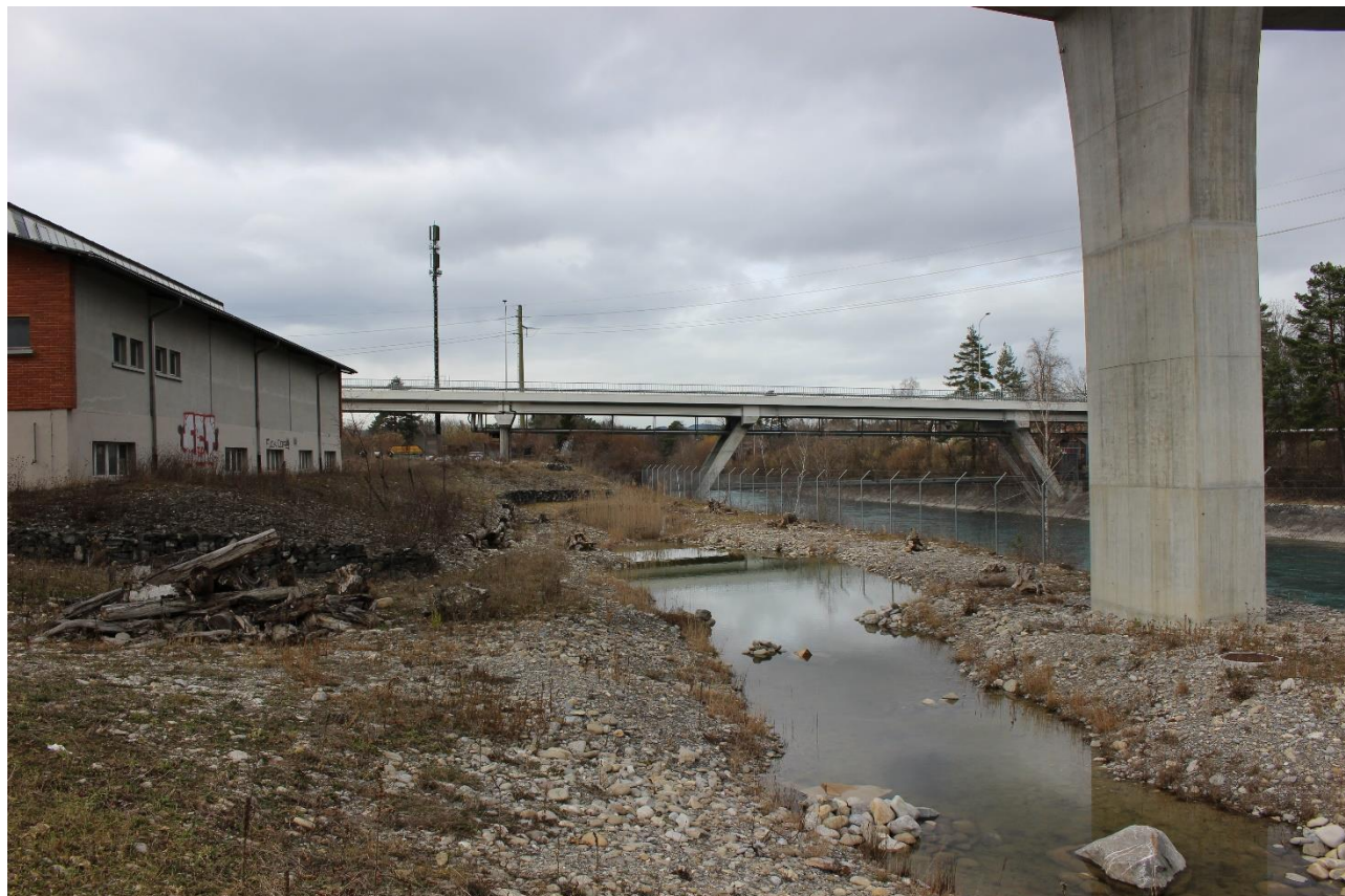
Bild: Aareufer Thun Nord unterhalb Alpenbrücke, Stadt Thun 2020
