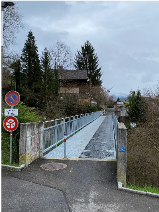
Abb. 1: Ausbau Brücke Dorfbach Hilterfingen
