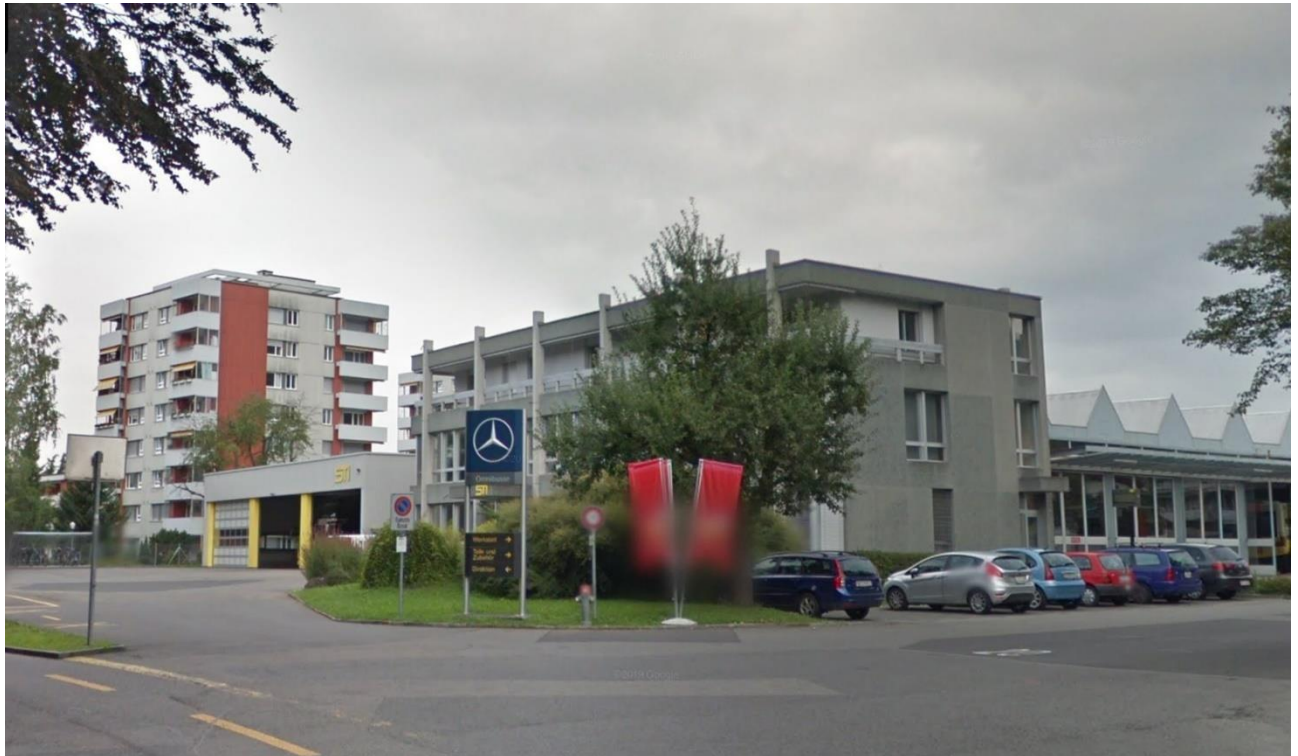
Foto: Areal STI-Grabengut, Quelle: Google, Streetview
