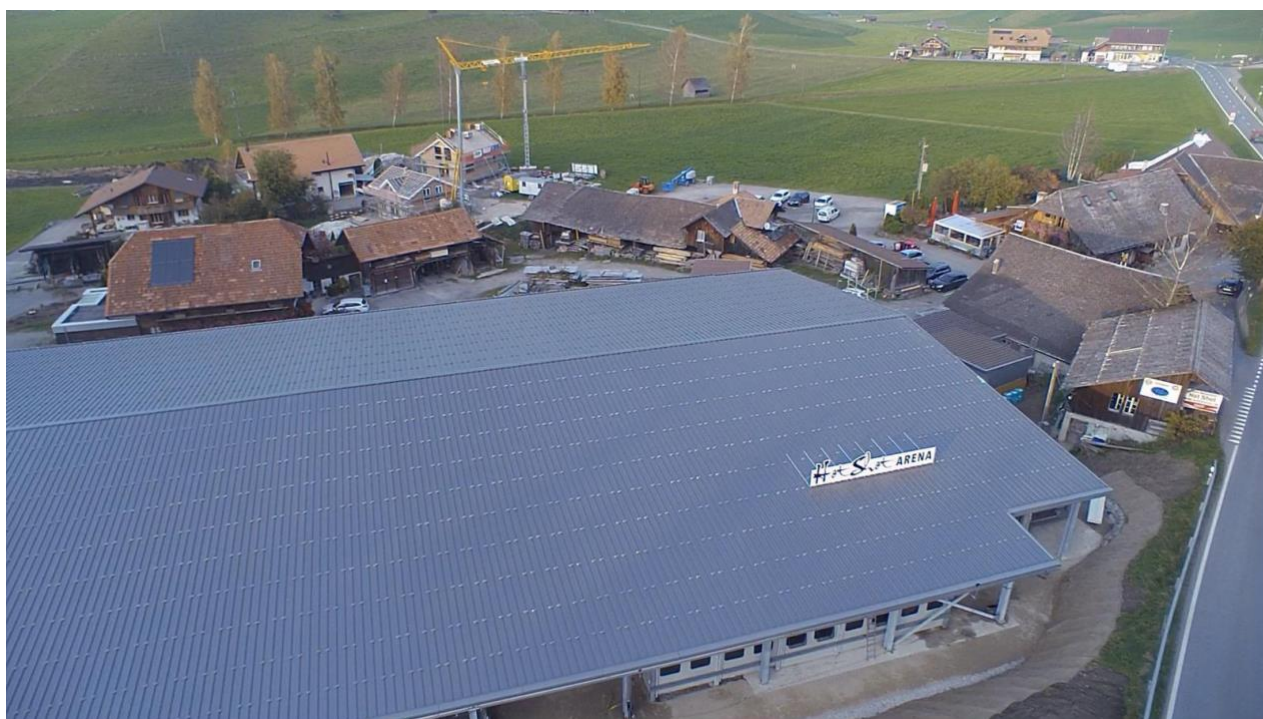
Nach dem Einbau einer neuen Kälteanlage soll auf dem Dach der Hot Shot Arena bald auch Solarenergie produziert werden. (Foto: 3H44 AG)
